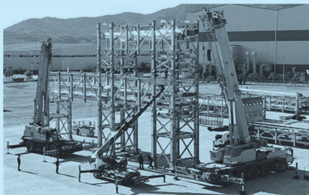
그림 12 모듈 가조립을 통한 모듈 간 정렬(alignment) 확인
