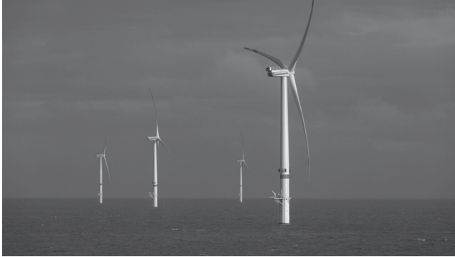
그림 6 MHI Vestas V164 모델로 조성한 독일의 해상 풍력 발전소(출처: MHI Vestas Offshore Wind.com)
