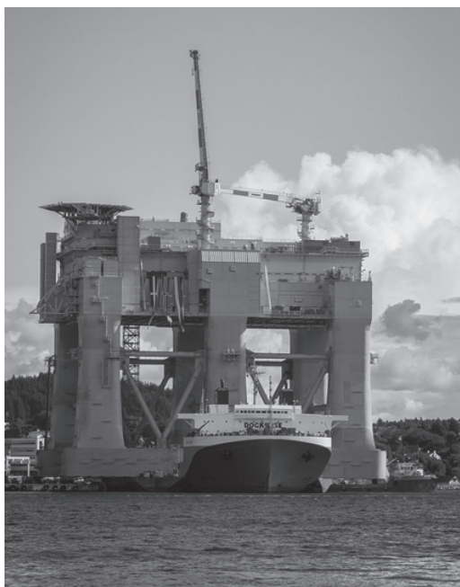
그림 11 노르웨이에서 설치를 위해 이동 중인 해상 풍력용 HVDC 변환 플랫폼(출처: wikipedia.org)
